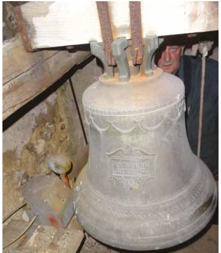
Insgesamt ist die Herstellung eines neuen Glockenstuhles aus Eichenholz erforderlich, entsprechende Platzfundamente müssen für die Statik neu geschaffen werden, die Glockenjoche sind in gutem Zustand, aber die Aufhängung und die Klöpel sind zu erneuern.
