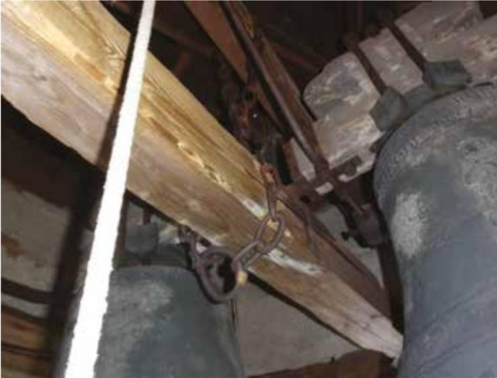
*Der mittlere Auflagebalken für die Glocken ist mit einer Kette behelfsmäßig am Turmdachstuhl gesichert!*
